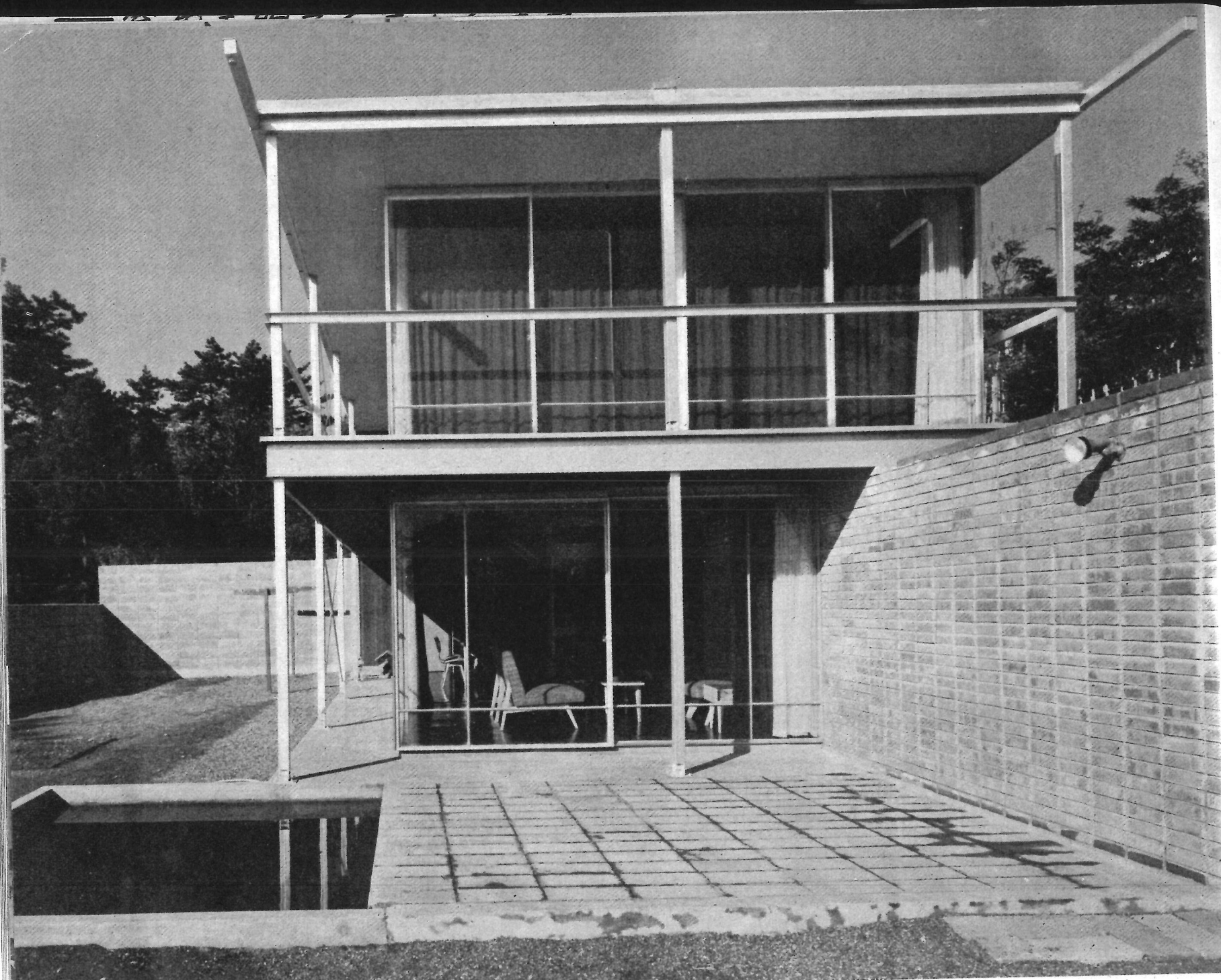
南面 South side view 鉄部は全てアルペストリーヒング仕上 右側の塀は煉瓦積みその裏は門から玄関へのアプローチ
