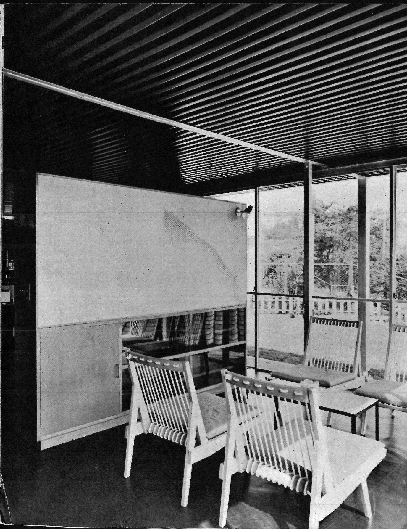
居間 左側の戸棚は食堂との間仕切を兼ねていて 居間から飾り戸棚 食堂から食器戸棚 家 事室の戸棚に使用 仕上 鉄骨とサツユはアルペースト 床 Nリノタイル貼り 天井 オイルペンキ 椅子は渡辺力デザイン Living room
