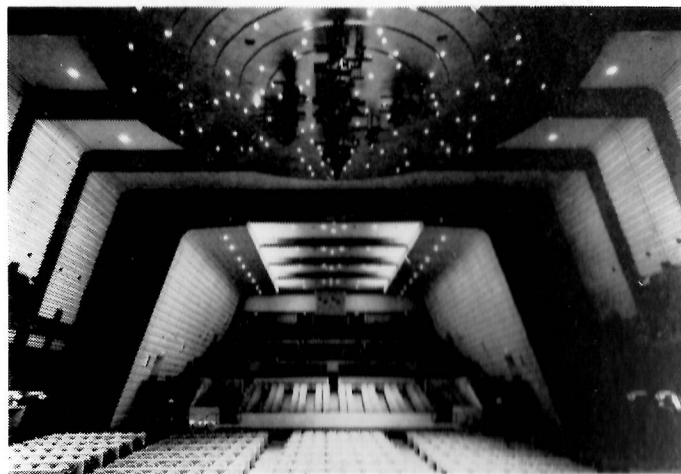
国立京都国際会館の内装仕上材として、セメントリーボードが大量に使用されています。
