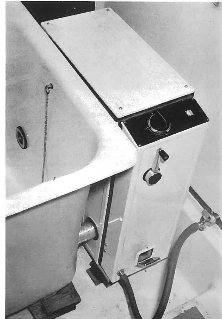
浴室内部 BF釜とホーロー浴槽
