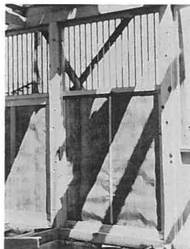
片面パネル取付
