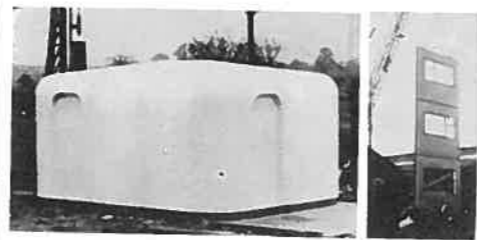
15. 信号リレー室
