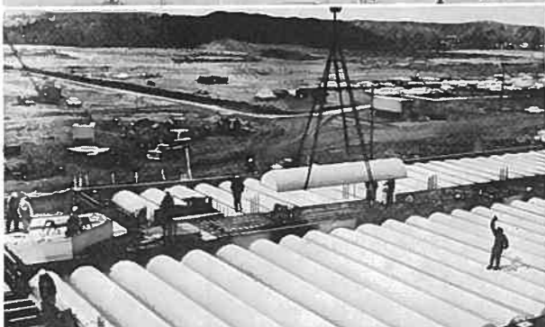
写真1-4 プラスチック半円筒型枠 教室の床のパレルヴォールト
