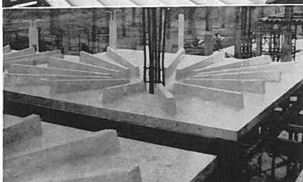
写真1-5 鋼製フレームの上にのせられたプラスチック製H・Pシェル型枠
