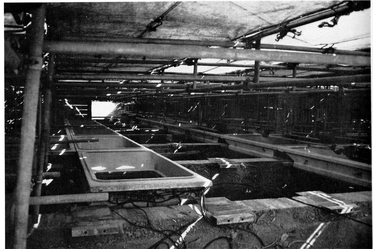
取付け現場を下から見上げたところ、4点でプレキャストが支えられる状況がよくわかる
