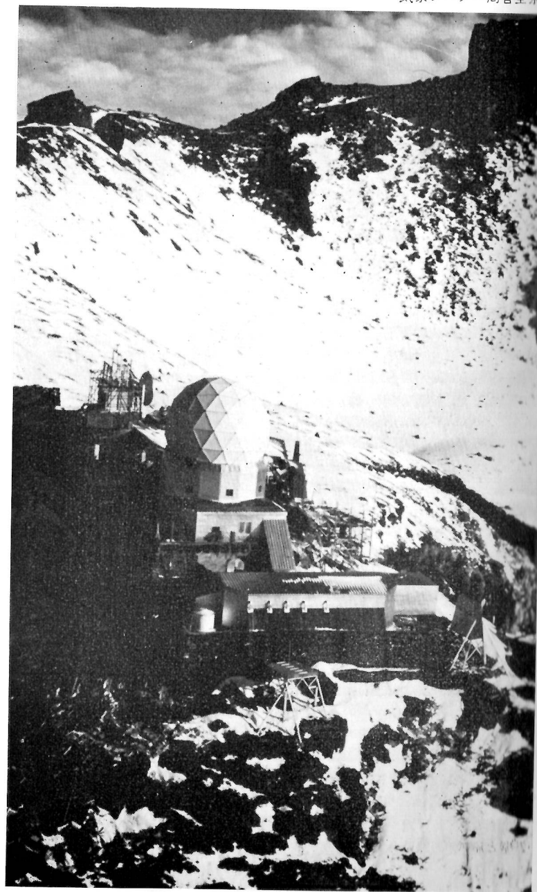
気象レーダー局舎全景
