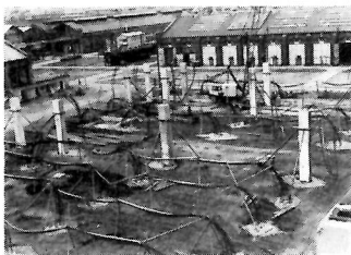
1：基礎にアンカーされてPC鋼線をプレキャスト柱に通し建方中
