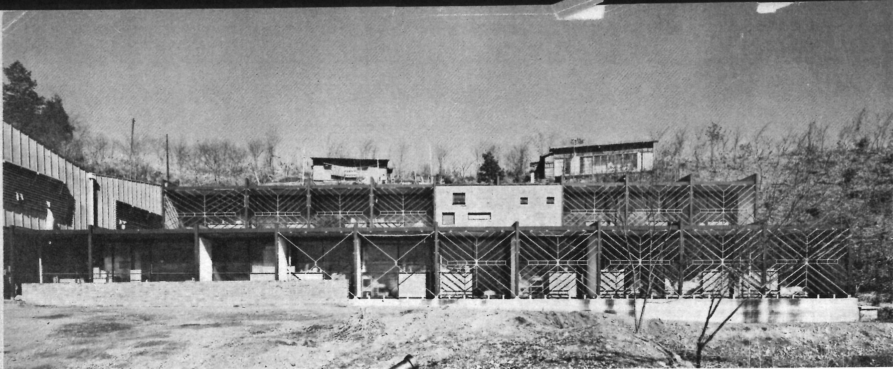
正面全景 Front general view 左側のバタフライは旧館・旧館との取合部分が新館の入口 格子のあるところが病室になっている
