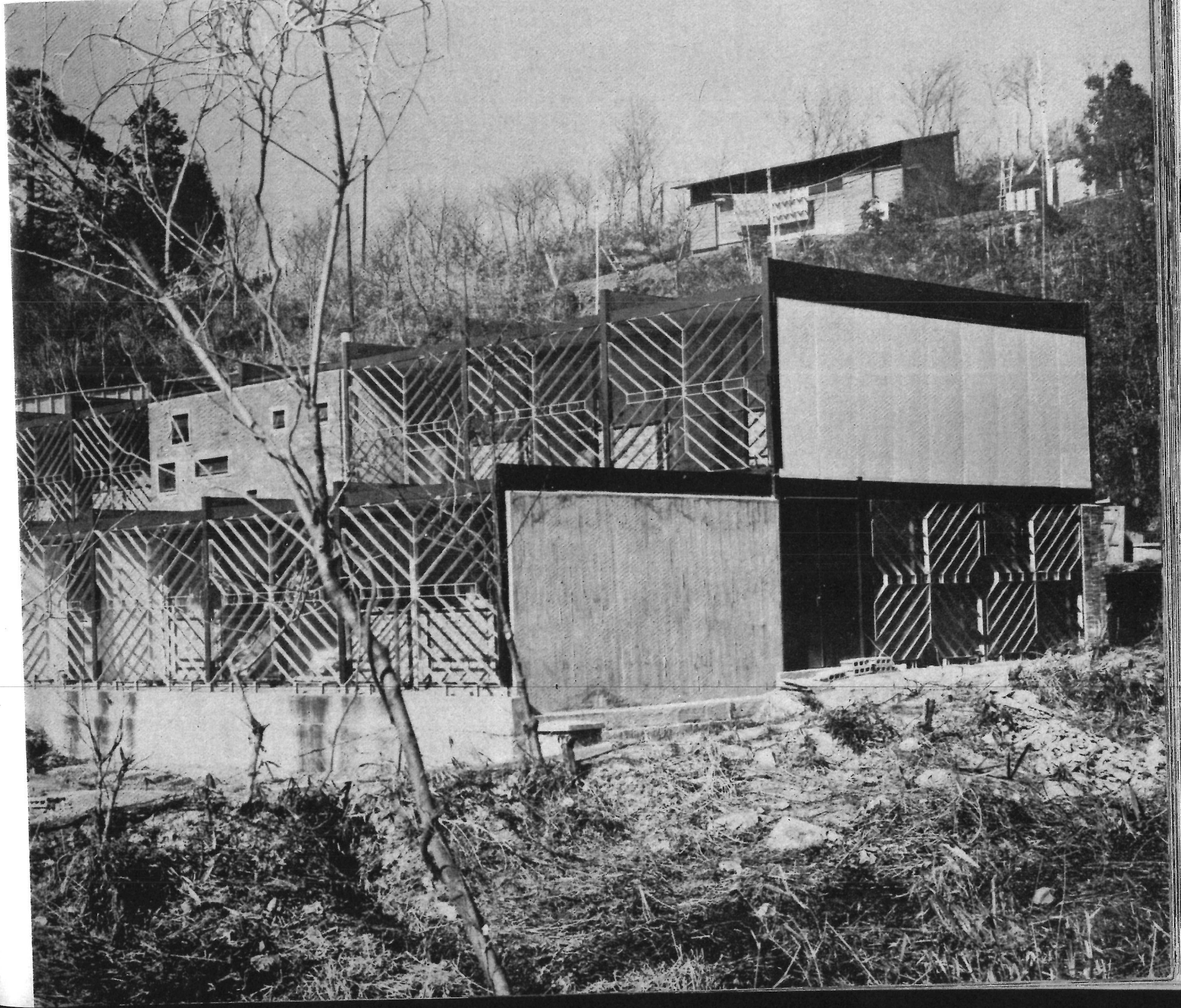
全景 General view 妻壁は2階がエレクションボード 1階がコンクリート打放し 格子は病室 2階正面中央の壁は煉瓦積み
