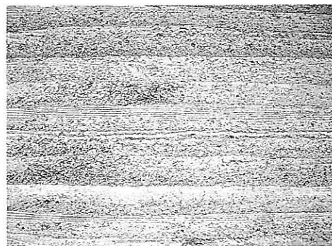
復原された版築の様子
