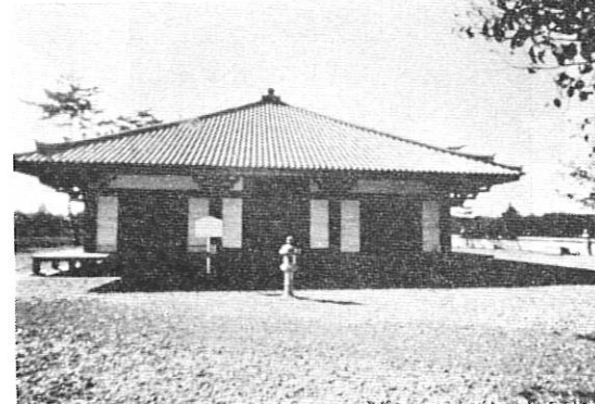
12世紀*兵庫県小野 外観/天竺様の典型。高床である。 内部/天井は張らず、構造がそのまま現われている。
