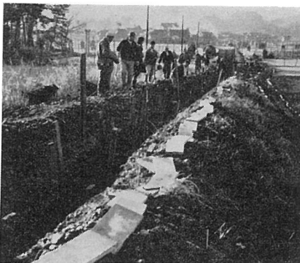
同軸ケーブルの工事
