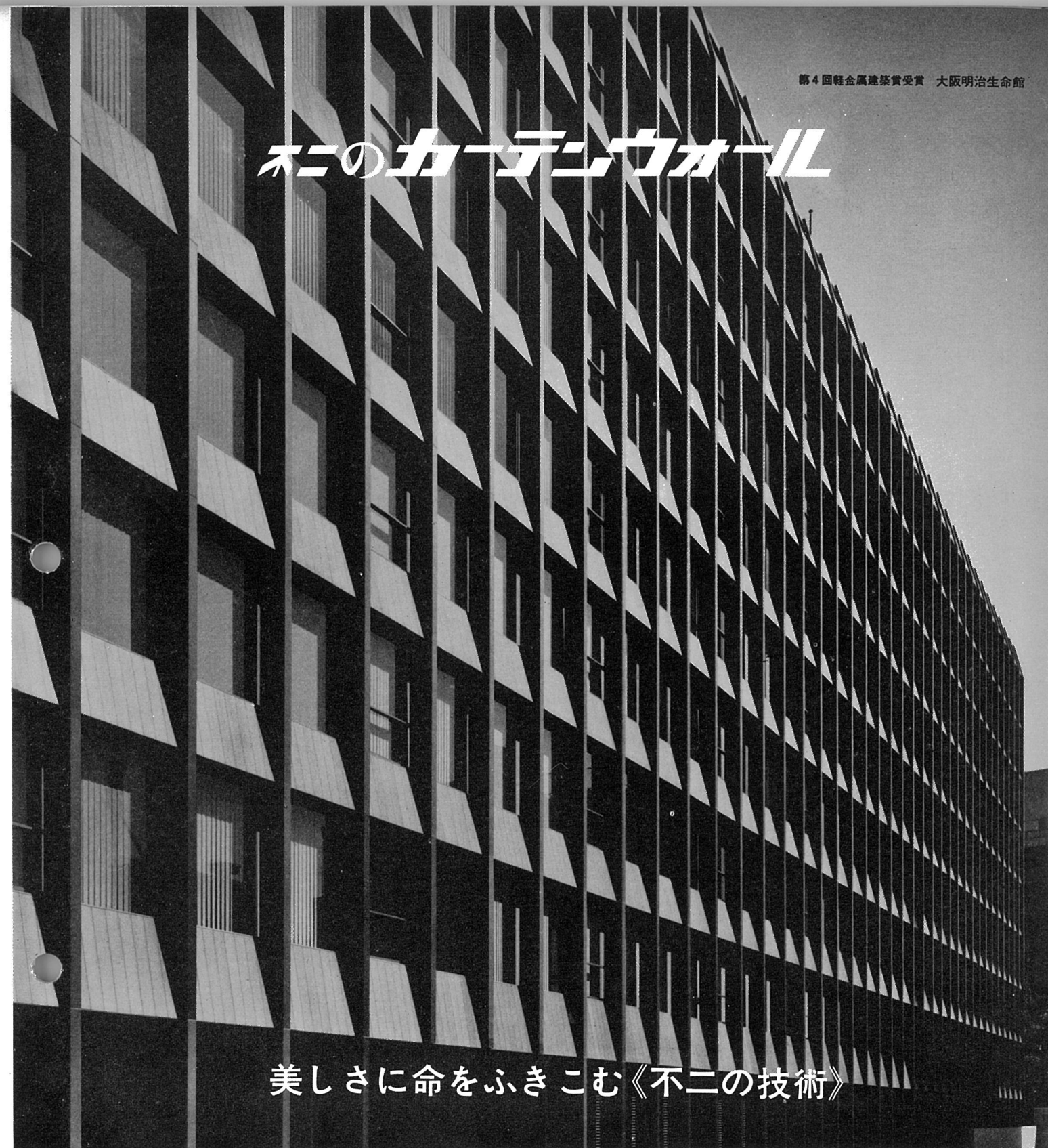
大阪明治生命館のカーテンウォール■押出型材によるカルカラーアンバー仕上げ
