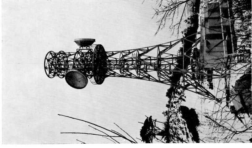
4 ユニット化されたマイクローエープ無線中継所
